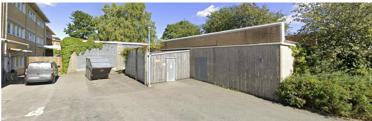
Figur 7 Bebyggelse som ska användas som bullerskydd // googlemaps.se
