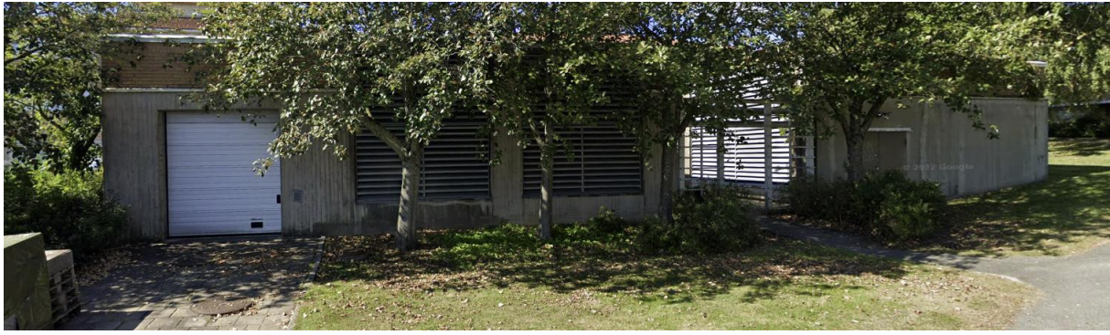
Figur 8 Bebyggelse som ska användas som bullerskydd // googlemaps.se
